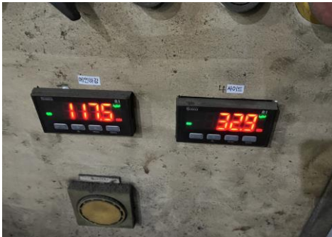
프레스 설비 메인하강 유압계 및 사이드 유압계 설치 및 데이터 수집
